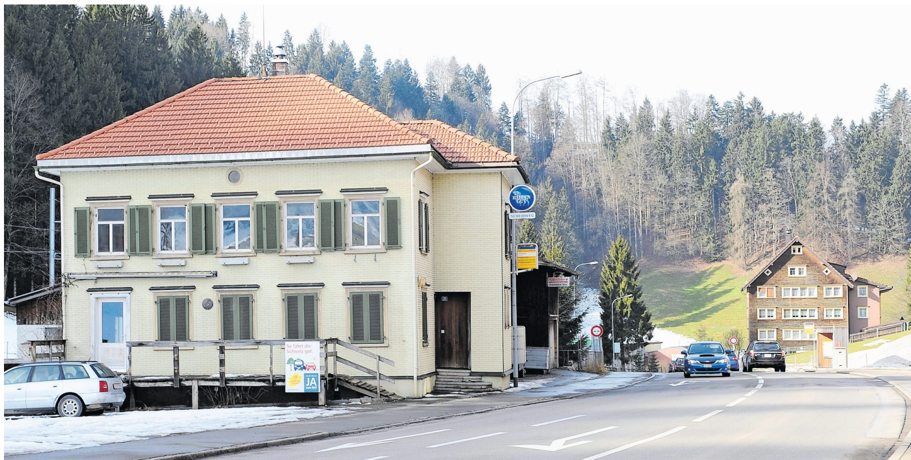
Zu Gunsten einer übersichtlicheren Kreuzung sollen das Restaurant Scheidweg und der angrenzende Stall bald abgerissen werden.
